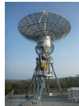
⑬勝浦宇宙通信所、⑭臼田宇宙空間観測所、⑮増田宇宙通信所、⑯沖縄宇宙通信所: 人工衛星などの追跡と管制のための電波の送信・受信を行う。
