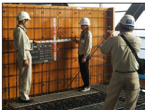
従来の配筋検査の様子
