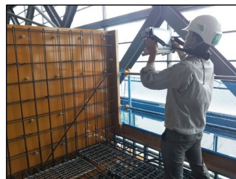
配筋検査システムによる計測の様子
