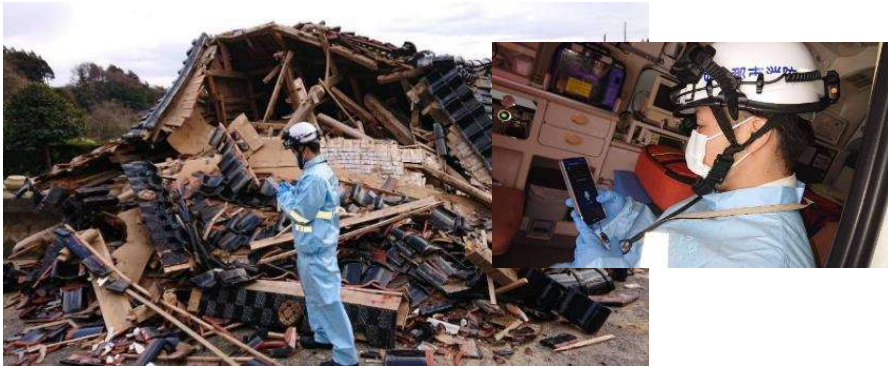
被災現場の活動で使用している様子
